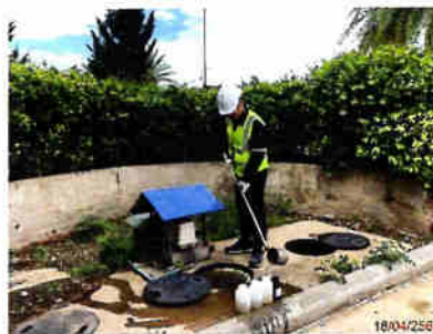
บ่อพักน้ำก่อนผ่านระบบบำบัดน้ำเสียอาคารที่พักผู้โดยสาร ขาเข้า
